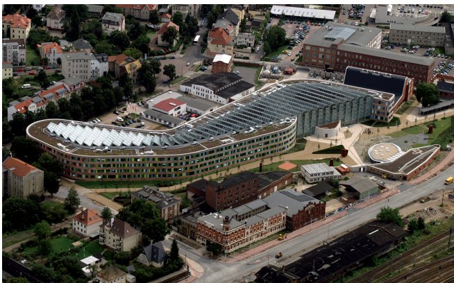
Umweltbundesamt in Dessau: Stadträumlicher Kontext (Foto: Busse)
